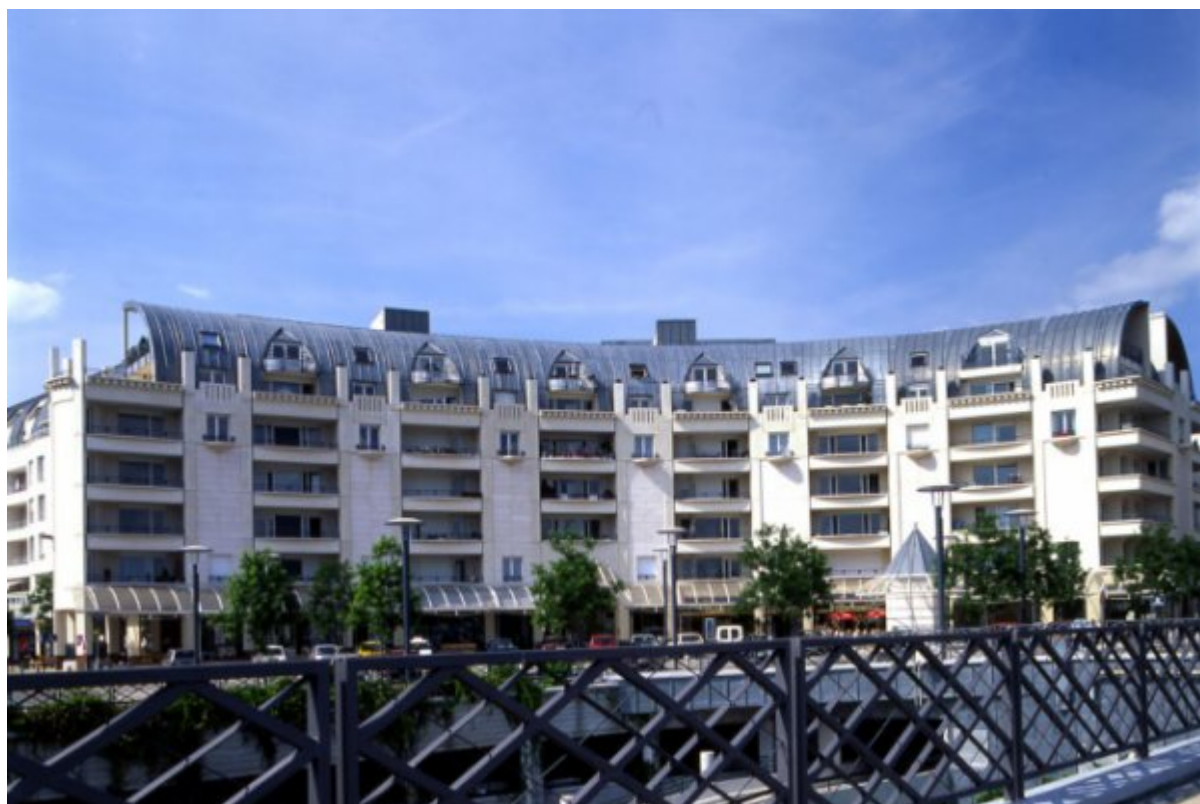
Les immeubles néo-haussmanniens des Hauts-de-Cergy
