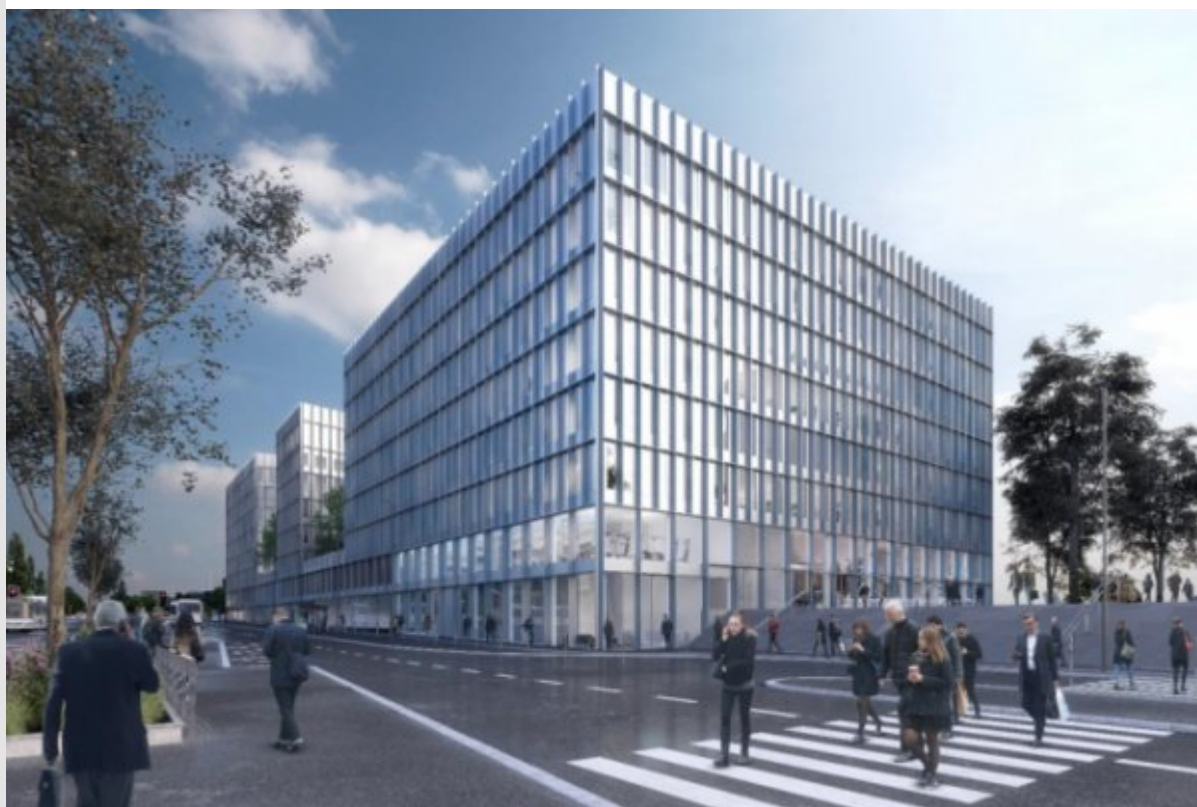
Perspective du futur bâtiment, aujourd'hui en construction.
